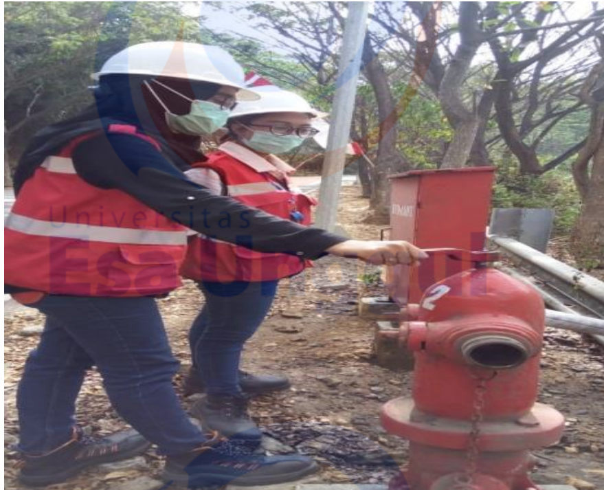
Gambar 2.6. Pengisian toren berkapasitas 40.000 Liter melalui hydrant .
