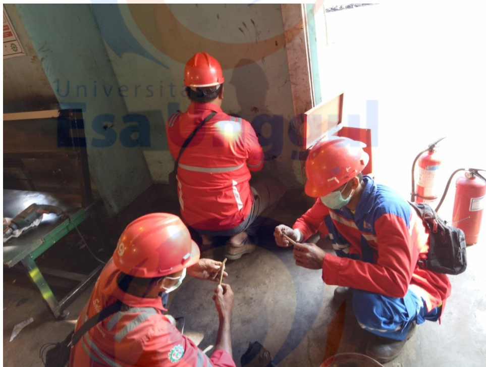
Gambar 2.19. Proses pemasangan Box APAR yang baru di Maintenance Building .
